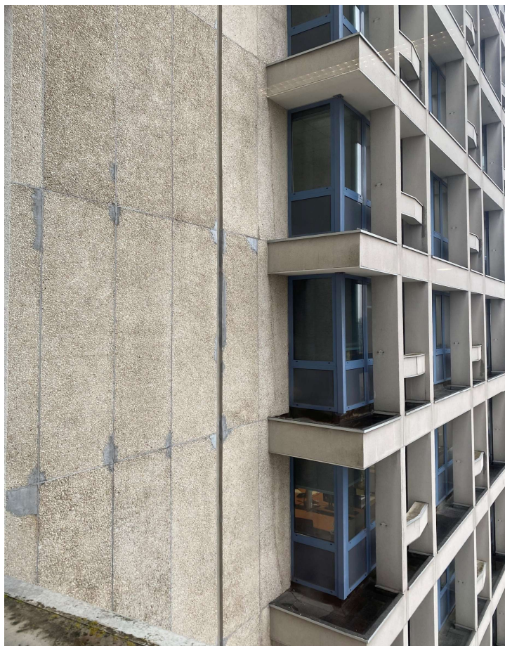
Panneaux préfabriqués de béton lavé sur les parties communes des tours (ascenseur, sanitaires, Escaliers, locaux techniques)
