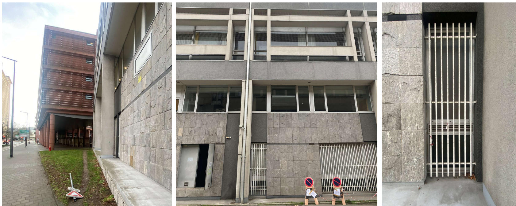
Détail de la façade du socle en bardage de pierre clivée – Présence de grille de protection sur les menuiseries du RDC – Casquettes en façades jouant brise soleil
